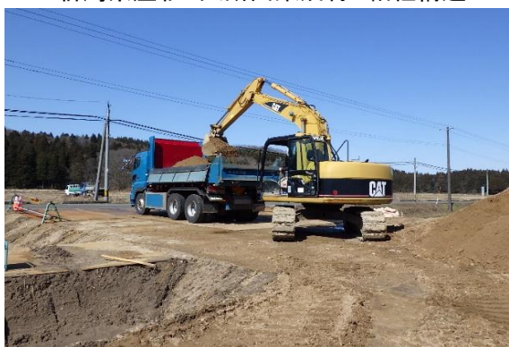
大型重機による土木作業
